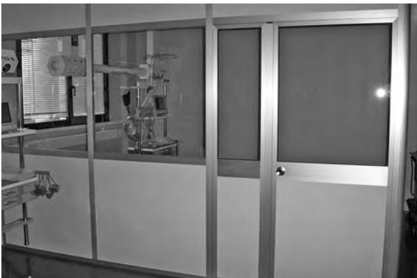
Figura 2. Box de aislamiento dentro de la Unidad.
